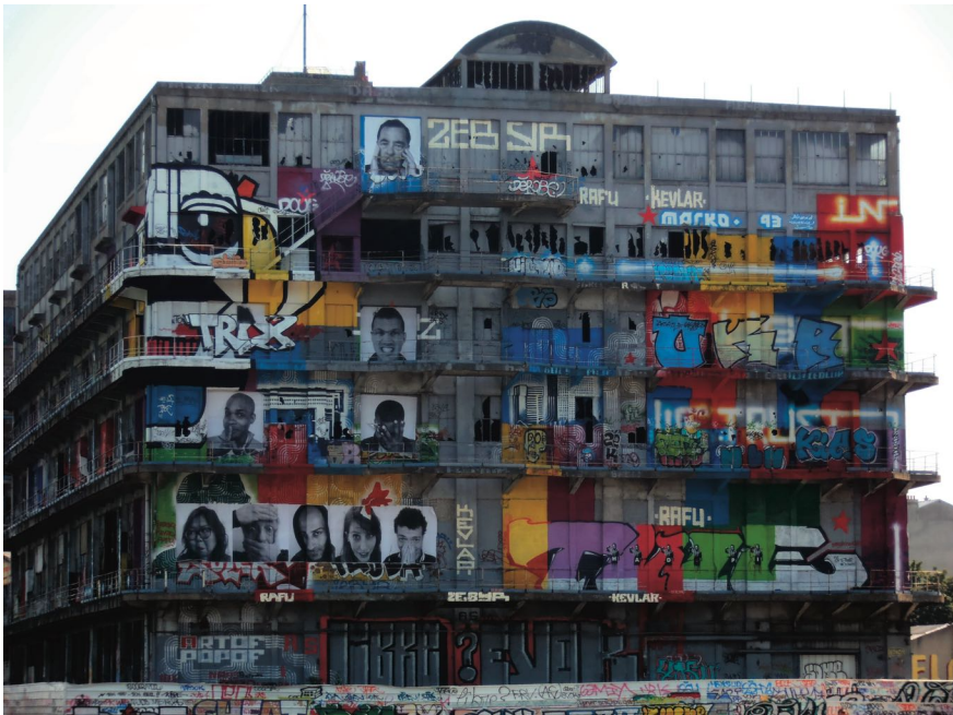
Figura 39: O edifício Pantin, antes da renovação, integralmente coberto de graffiti .
